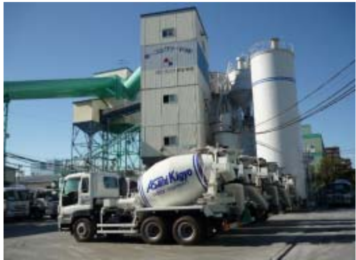
写真 港北営業所(第一コンクリート㈱ 港北工場)
