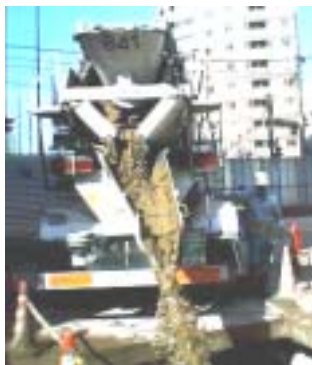
写真 地下3階埋め戻し作業、
